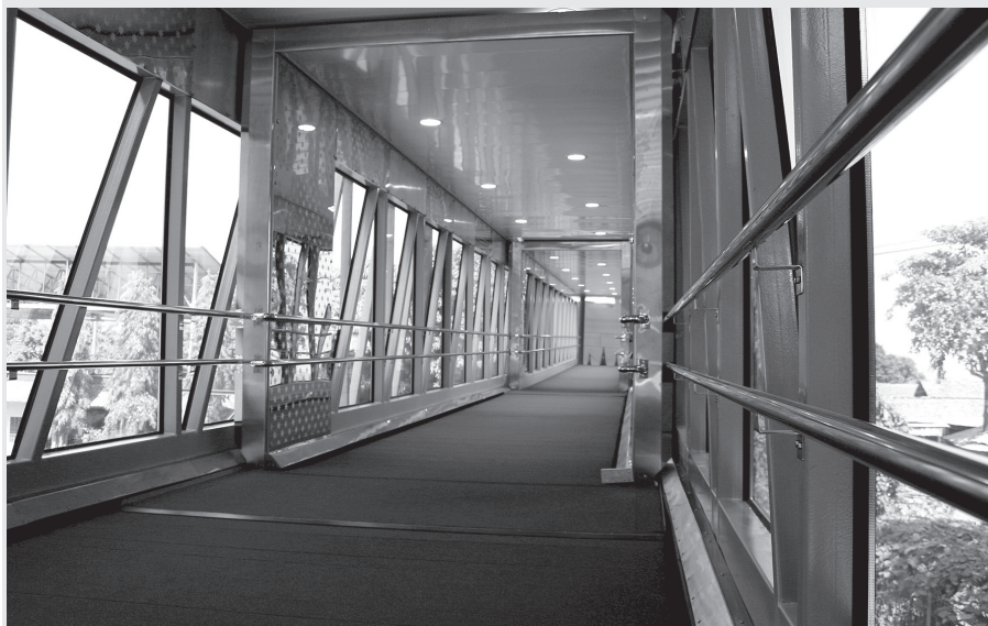
段差の無くなった「イージーウォーク」の内部(提供:全日空モーターサービス)
